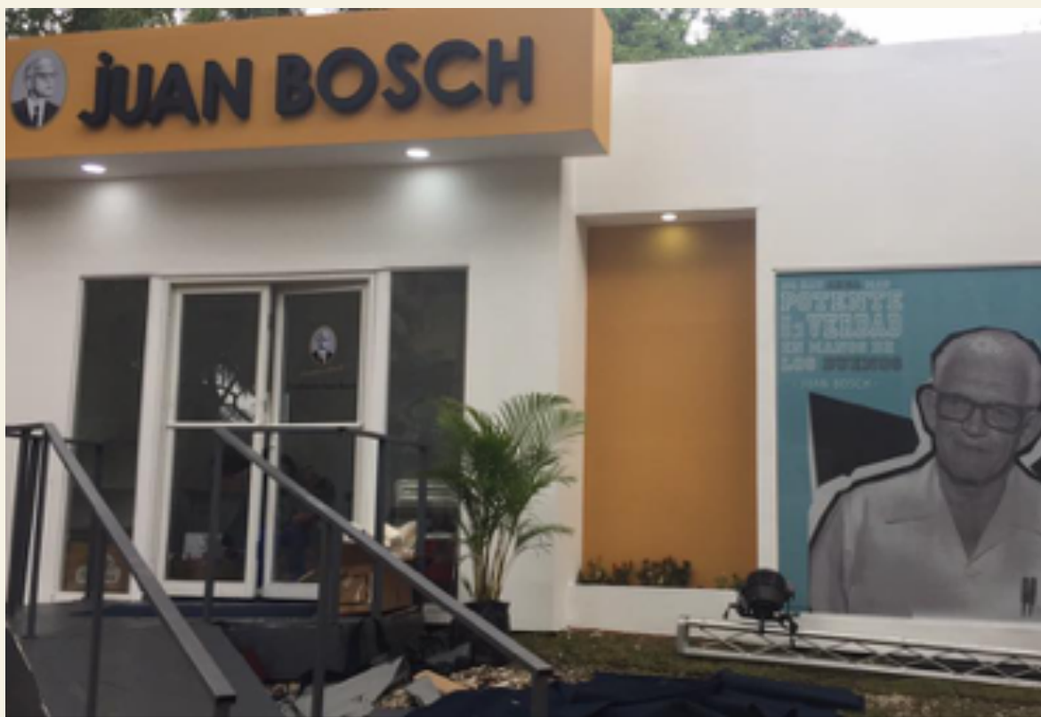
Vista frontal del pabellón de la Fundación Juan Bosch.
